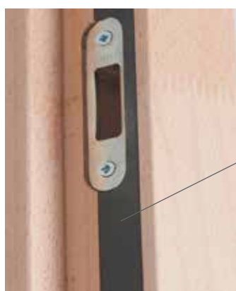
Joint intumescent intégré à l'huissérie
